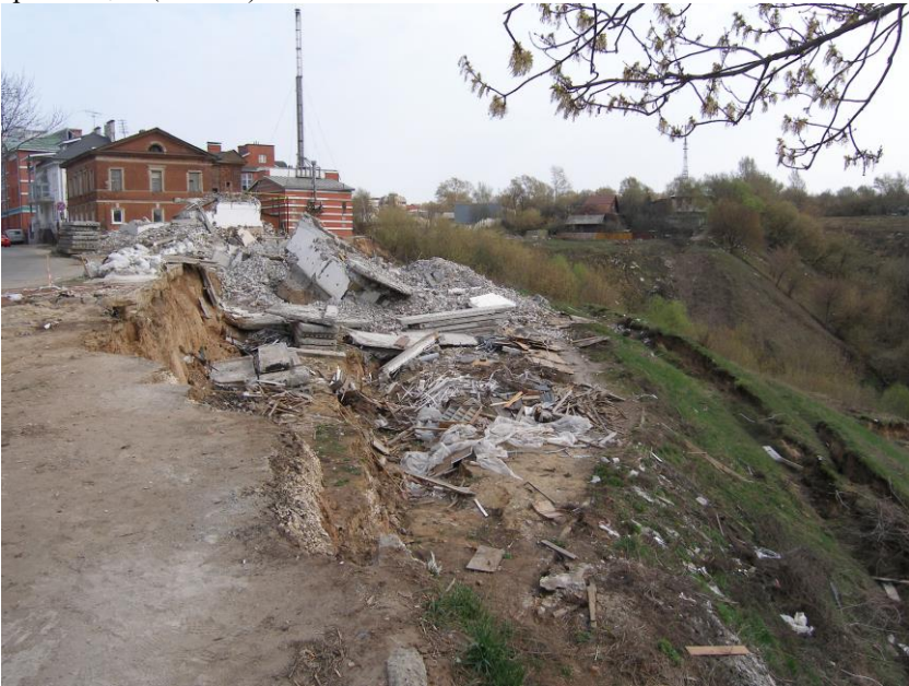
Рис. 17. Оползень при насыщении рыхлого грунта водой.
