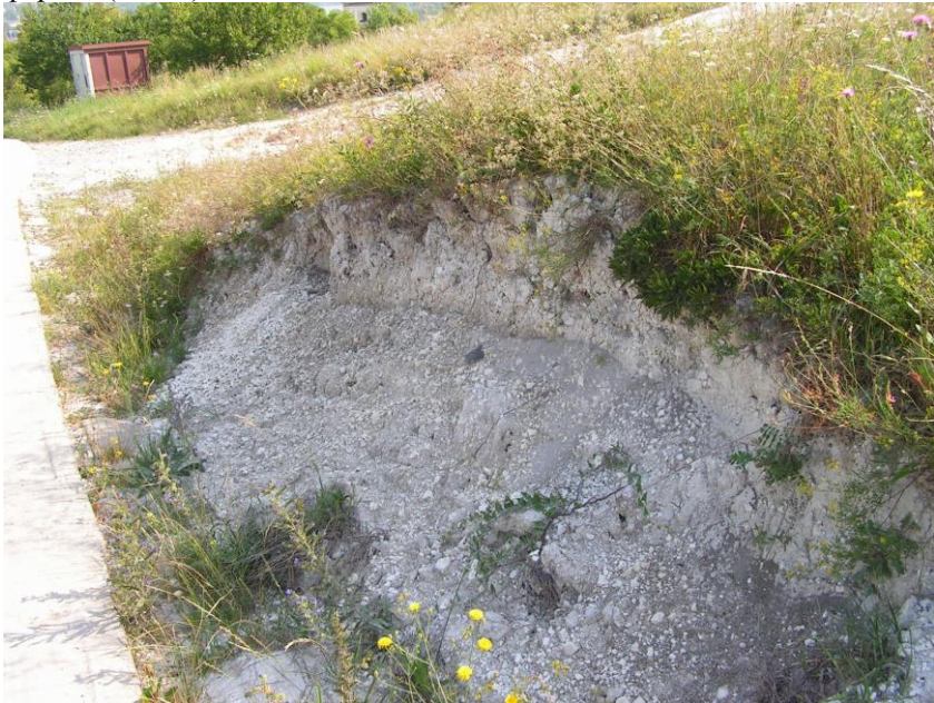
Рис. 4. Выветривание выхода мела на поверхность.
