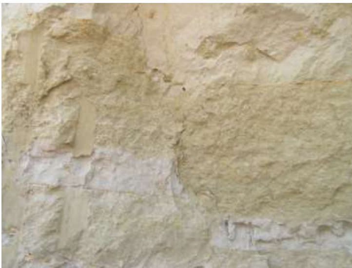
Рис. 2. Сброс пропластка песка по тектонической трещине
