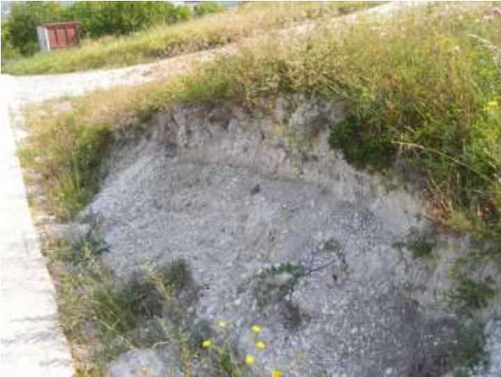
Рис. 4. Выветривание выхода мела на поверхность.
