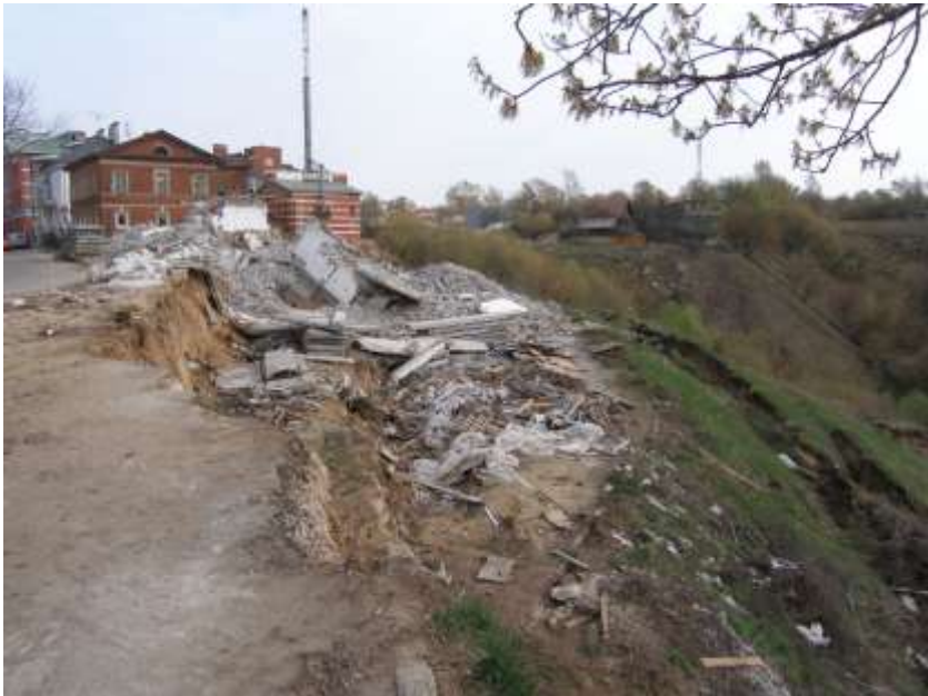
Рис. 17. Оползень при насыщении рыхлого грунта водой.
