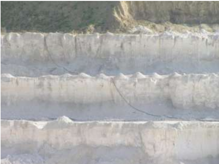
Рис. 16. Осыпь грунтов под углом естественного откоса уступов карьера
